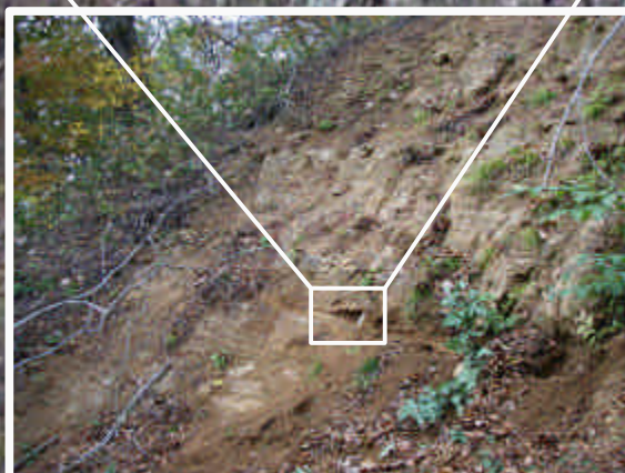
写真-7 層面断層と重力性の変位を示唆する亀裂群
