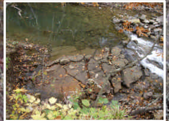
写真-2 溪床岩盤の跳ね上がり
